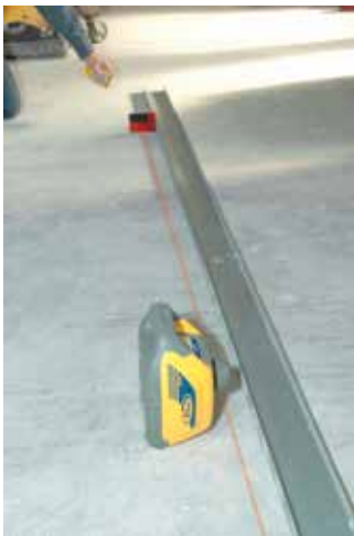
Aplicación de alineación vertical
