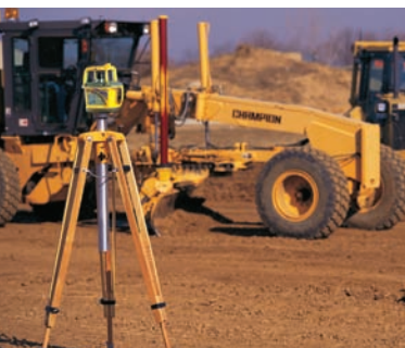
Construcción de carreteras
