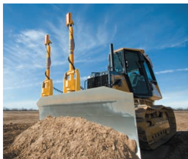
Preparación de la obra
