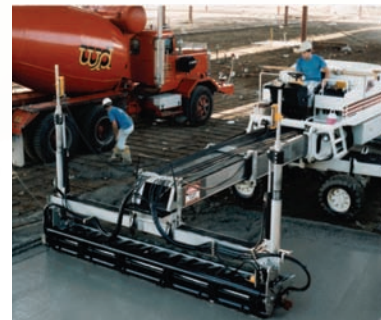
Construcciones de hormigón
